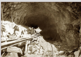
Construção do túnel Coruja - Austria não identificada [Década de 1950] Acervo: Roque Coser
