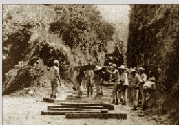
Colocação de dormente e trilhos em São Luis das Antas Austria não identificada - [Década de 1940] - Acervo: Roque Coser
