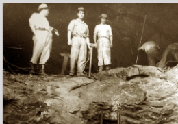
Construção do Túnel Jaboticaba - Austria não identificada - [1956] Acervo: Roque Coser
