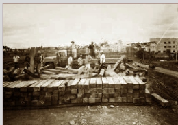
Correçamento de dormentes na Estação de Bento Gonçalves Austria não identificada [Década de 1950] - Acervo: Roque Coser
