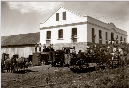
Grupos de homens transportando carregamentos de uvas para a Adega de Ângelo Antonello & Cia., que seria a cantina central da Sociedade Vinícola Rio Grandense Ltda. e, posteriormente, filial da empresa. Vê-se vagão de trem próximo ao prédio, já que o mesmo era contíguo à linha férrea do município. Farroupilha, [déc. 1930] – Foto: Studio Geremia – Acervo: Arquivo Histórico Municipal João Spadari Adami.
