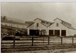
Construção da Oficina de Garibaldi – [1919] – Autoria não identificada. Acervo: NPPHF - Núcleo de Preservação de Pesquisa Histórica Ferroviária
