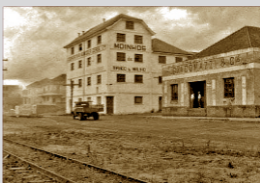
Moinho Ceres de Trigo e Milho, instalado em frente a estação férrea de Bento Gonçalves – [déc. 1950] – Autoria não identificada – Fonte: Instituto Histórico e Geográfico Brasileiro.
