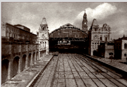
Construção da Estação da Luz/SP – Autoria: Marc Ferrez – [1896] Coleção Gilberto Ferrez – Acervo: Instituto Moreira Sales
