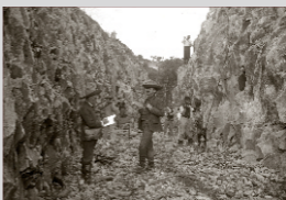
Vistoria das obras de construção do ramal ferroviário Montenegro – Caxias do Sul Operários e técnicos trabalhando, o primeiro à esquerda é Albano Coelho de Souza e em sua frente seu filho, Engenheiro agrônomo Leônidas Coelho de Souza, que trabalhou na construção da estrada de 1905 até 31 de janeiro de 1910. Autoria: Domingos Mancuso – [1910]. Doação: Francisco Fortuna Acervo: Arquivo Histórico Municipal João Spadari Adami.
