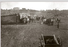
Obras de preparação do terreno para Construção da Estação Férrea de Caxias do Sul. Ao fundo vê-se a igreja de Santa Teresa, atual Catedral - Caxias - [1910]. Autoria: Domingos Mancuso. Doação Francisco Fortuna Acervo Arquivo Histórico Municipal João Spadari Adami.
