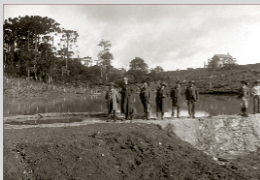
Vistoria das obras de construção da Estrada de Ferro, ramal ferroviário Caxias - Montenegro. Caxias do Sul [1909]. Autoria: Domingos Mancuso. Doação Francisco Fortuna. Fundo Domingos Mancuso – Acervo: Arquivo Histórico Municipal João Spadari Adami.
