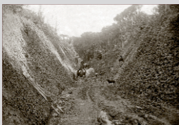
Vistoria das obras de construção da Estrada de Ferro Montenegro – Caxias do Sul Autoria: Domingos Mancuso – [1909] – Doação Francisco Fortuna Acervo: Arquivo Histórico Municipal João Spadari Adami.
