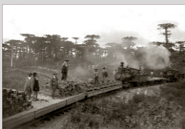
Carregamento de dormentes para as obras e construção do Ramal Montenegro - Caxias do Sul com auxílio da Maria Fumaça - Autoria: Domingos Mancuso - [1910] Doação Francisco Fortuna - Acervo: Arquivo Histórico João Spadari Adami.
